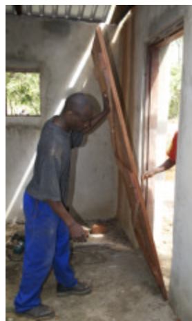
Gabriel installing a door
